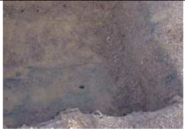
Abbildung 2: Verdichtete Rasentragschicht mit typischer Marmorierung
